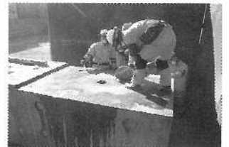
破壊器具でコンクリートを破壊する。
