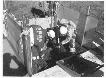
二次災害防止のため応急土留めを設定。
