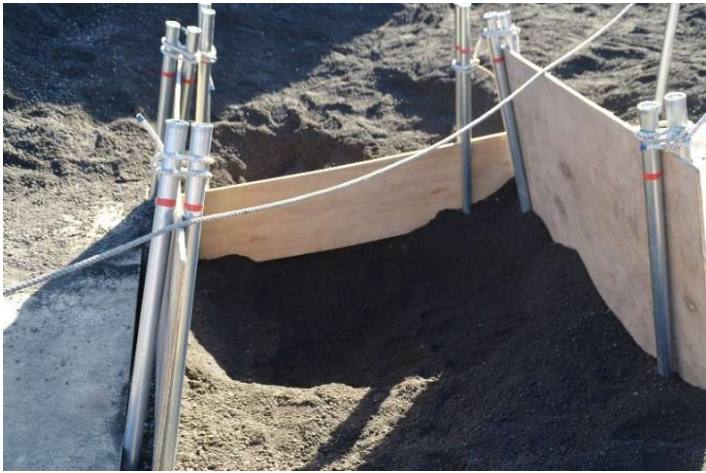
救出が無事終了した箇所、安全を考慮し埋め戻してあります。
