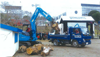
九都県市合同防災訓練で倒木除去を実施
