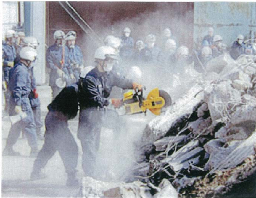
機材を使ってがれきの撤去も行われた 23日、八街市八街への大同産業(県警提供)
