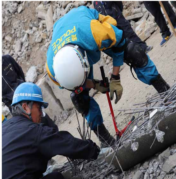
倒壊した電柱を破碎する訓練。ハンマーでたたいた後、中の鉄筋を切断した
