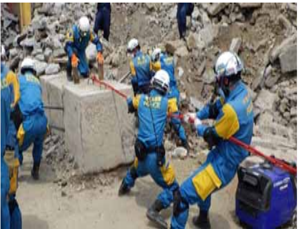
訓練でコンクリートの撤去作業にあたる参加者たち(八街市で)
